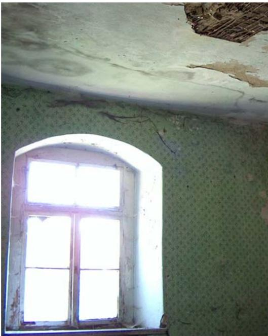
Gesamteindruck: Die Bauteile besitzen normale Altersspuren, sie sind stark abgenutzt. In ungenutzten Räumen des Gebäudes sind die Rahmenhölzer durchfeuchtet und zugequollen, so dass kaum noch Fugenlüftung vorhanden ist.
