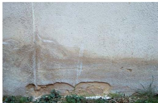
Abbildung 4—29; Salz- und Feuchtigkeitsschäden an Sanierputz – 5 Jahre nach Fertigstellung
