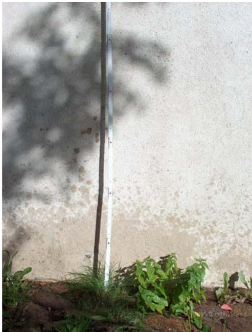
Abbildung 4—17, Natursteinbelag vor der Hauswand; starke Durchfeuchtung - bis 0,5 m Sockelhöhe
