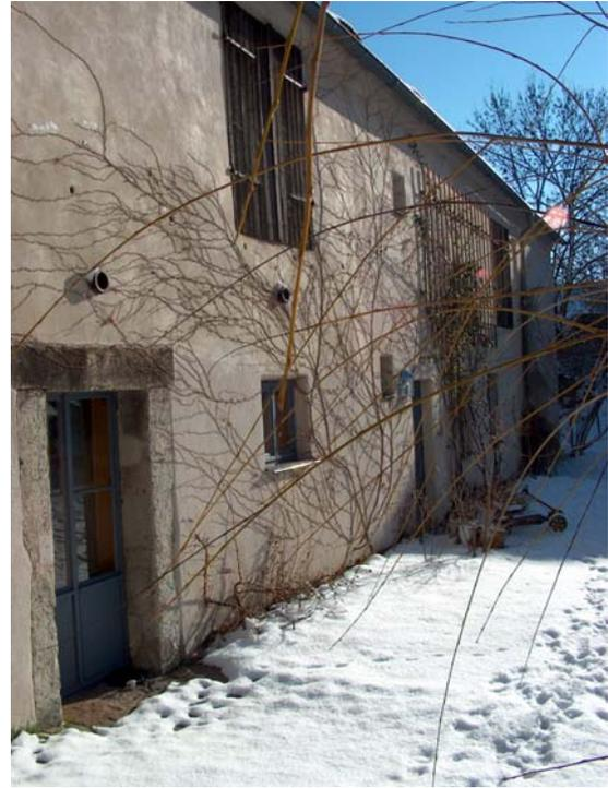
Abbildung 4—35, Reppnitzer Rittergut, intakter Putz am ehemaligen Rinderstall, 8 Jahre nach Fertigstellung
