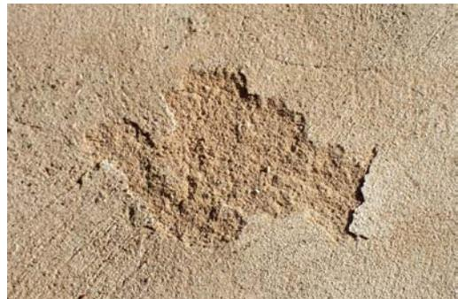
Abbildung 4—27; Salz- und Feuchtigkeitsschaden an Kalkputz – ½ Jahr nach Fertigstellung
