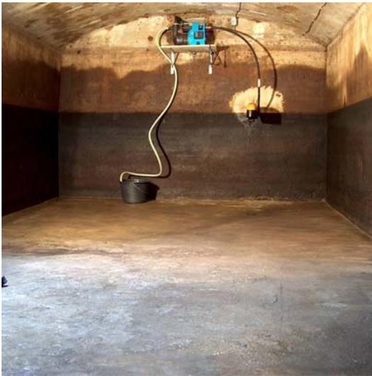
Abbildung 3—18, Beispiel einer leer gepumpten Grube,
