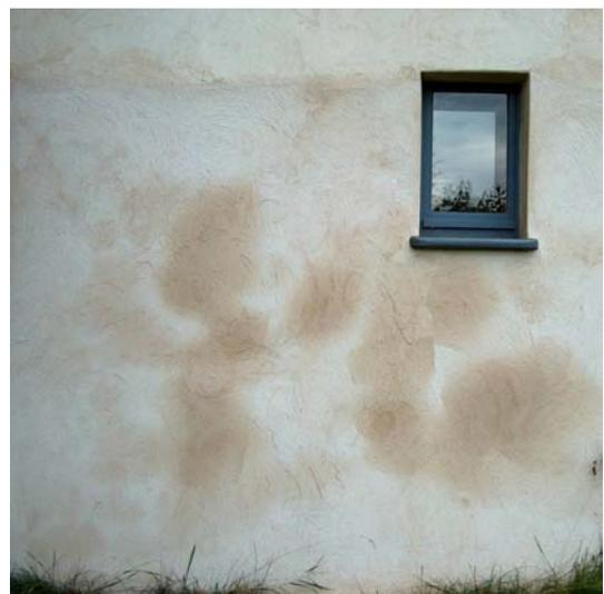
Abbildung 4–23, Beispiel für hygroskopische Wasseraufnahme einer Außenwand
