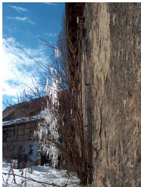
Abbildung 4—19, Einfache Grasnarbe kann die Spritzwasserbelastung des Sockels erheblich reduzieren – hier zu sehen: die Wasser brechende Wirkung eines verzweigten Gesträuches.
