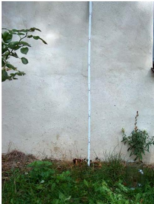
Abbildung 4—18, Grasnarbe bis zur Hauswand - kaum Befeuchtung der Wand
