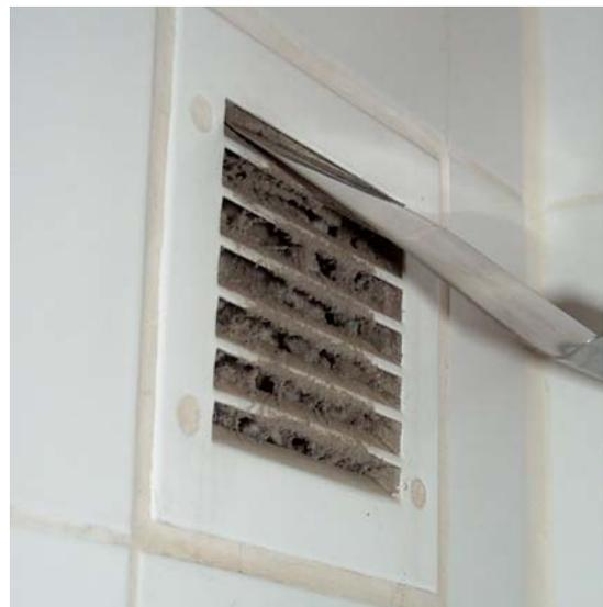
Abbildung 4—51, Abluftöffnung an einem Schornsteinzug (natürliche Lüftung); Thermischer Auftrieb gewährleistet eine kontinuierliche Lüftung in der kalten Jahreszeit. Im Sommer können kleine Gebläse die Luftbewegung unterstützen. (die Filterwirkung der Schachtöffnung verdeutlicht die Luftbewegung)
