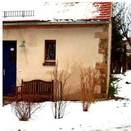
Abbildung 4—10, Reppnitzer Rittergut, durchfeuchteter Bauwerkssockel nach der Sanierung
