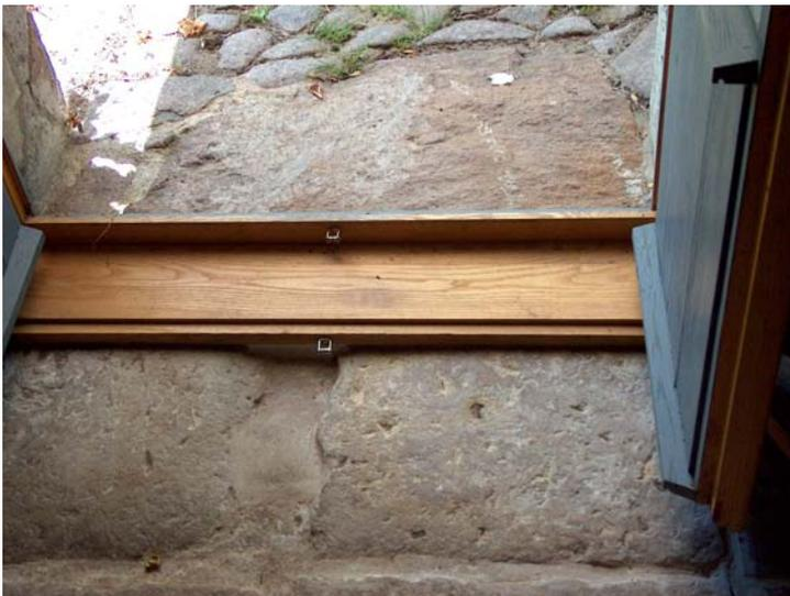
Abbildung 4—41, Ebenerdige Verbindungen von Innen- und Außenraum sind im Grünen - auf dem Land besonders angenehm. Natursteine sind – wo es möglich ist - im Leibungsbereich durch Dämmstreifen zu trennen.
