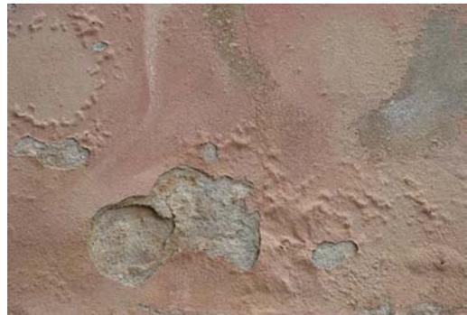
Abbildung 4—28; Salz- und Feuchtigkeitsschaden an Kalkzementputz – 1 Jahr nach Fertigstellung
