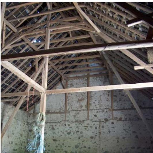
Schäden entstanden hauptsächlich dort, wo unterhalb des schadhaften Daches gute Feuchtespeicher vorhanden waren (z.B. Lagergut, saugfähiges Mauerwerk usw.).
